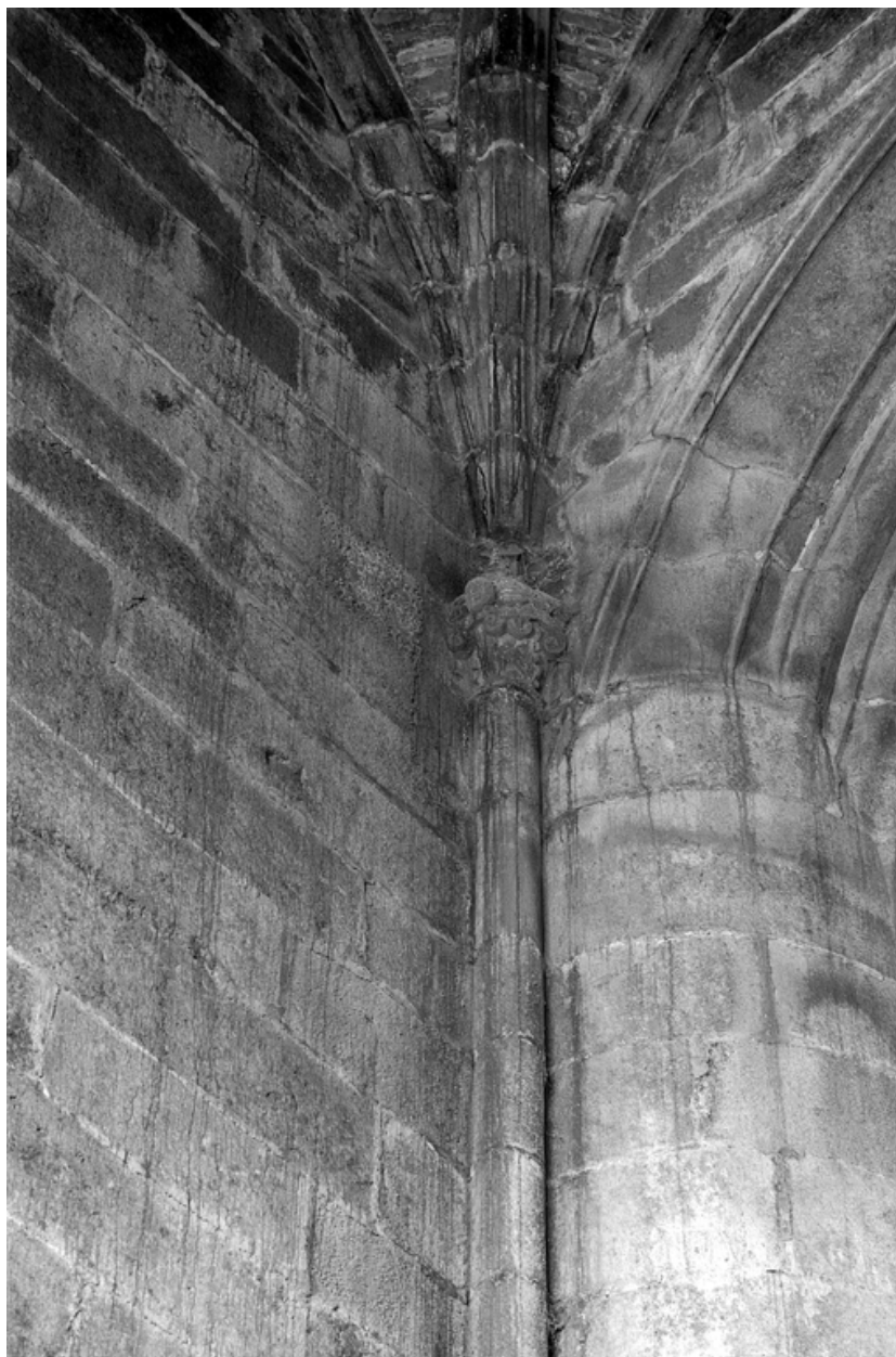
Tour ouest : voûte du rez-de-chaussée, retombée d'une ogive
