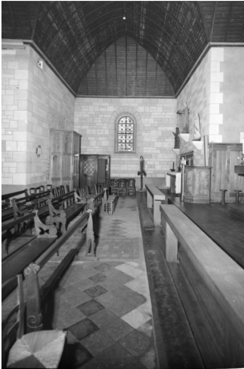
Intérieur, bras Nord du transept : vue générale.
