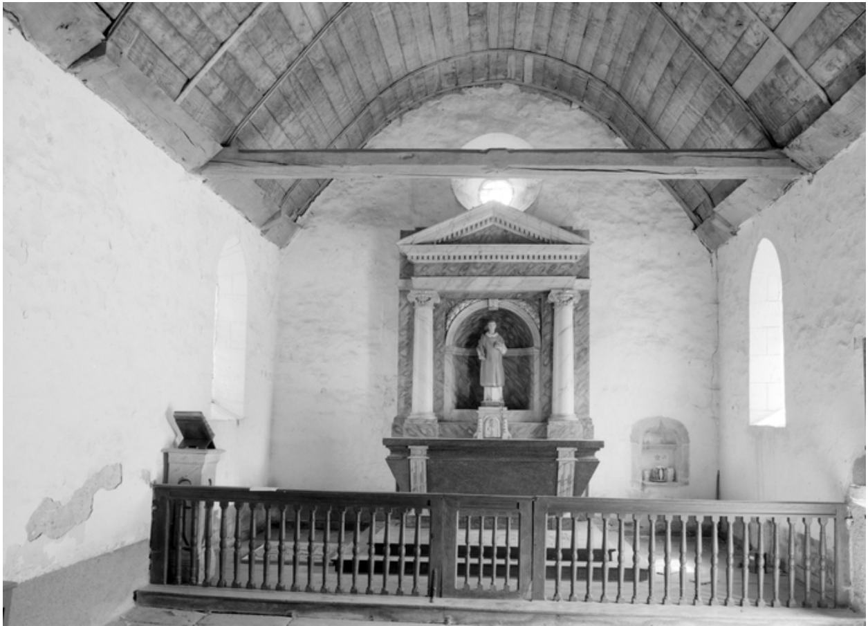
Chapelle Saint-Étienne : vue générale vers le choeur (état en 1984)
