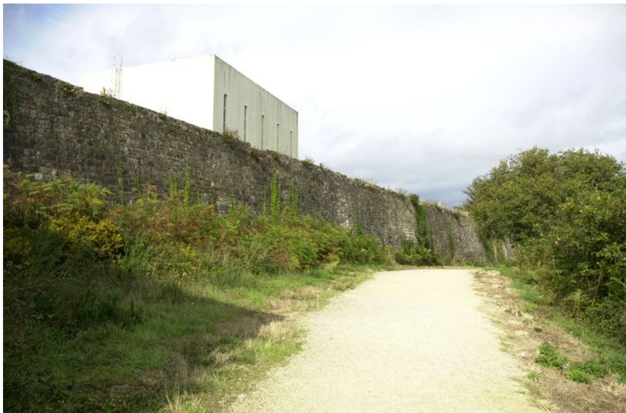
Vue du fort de Lanvéoc : cortine
