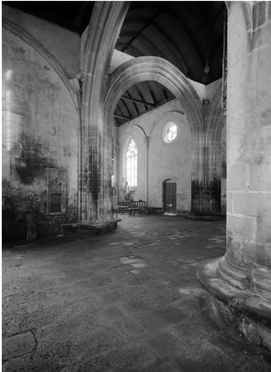
Vue générale de la croisée du transept.
