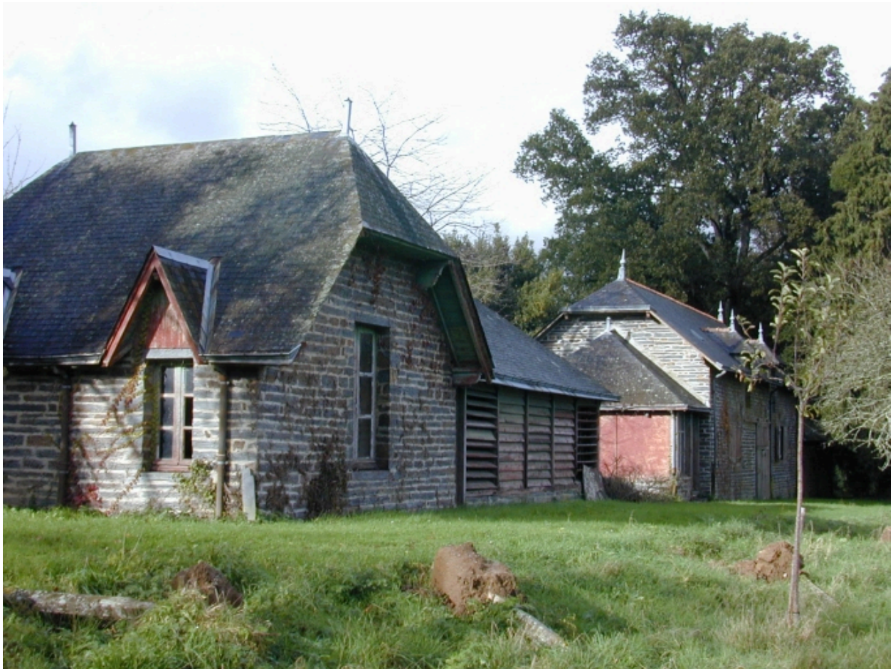
Vue de la lavanderie et de la scierie
