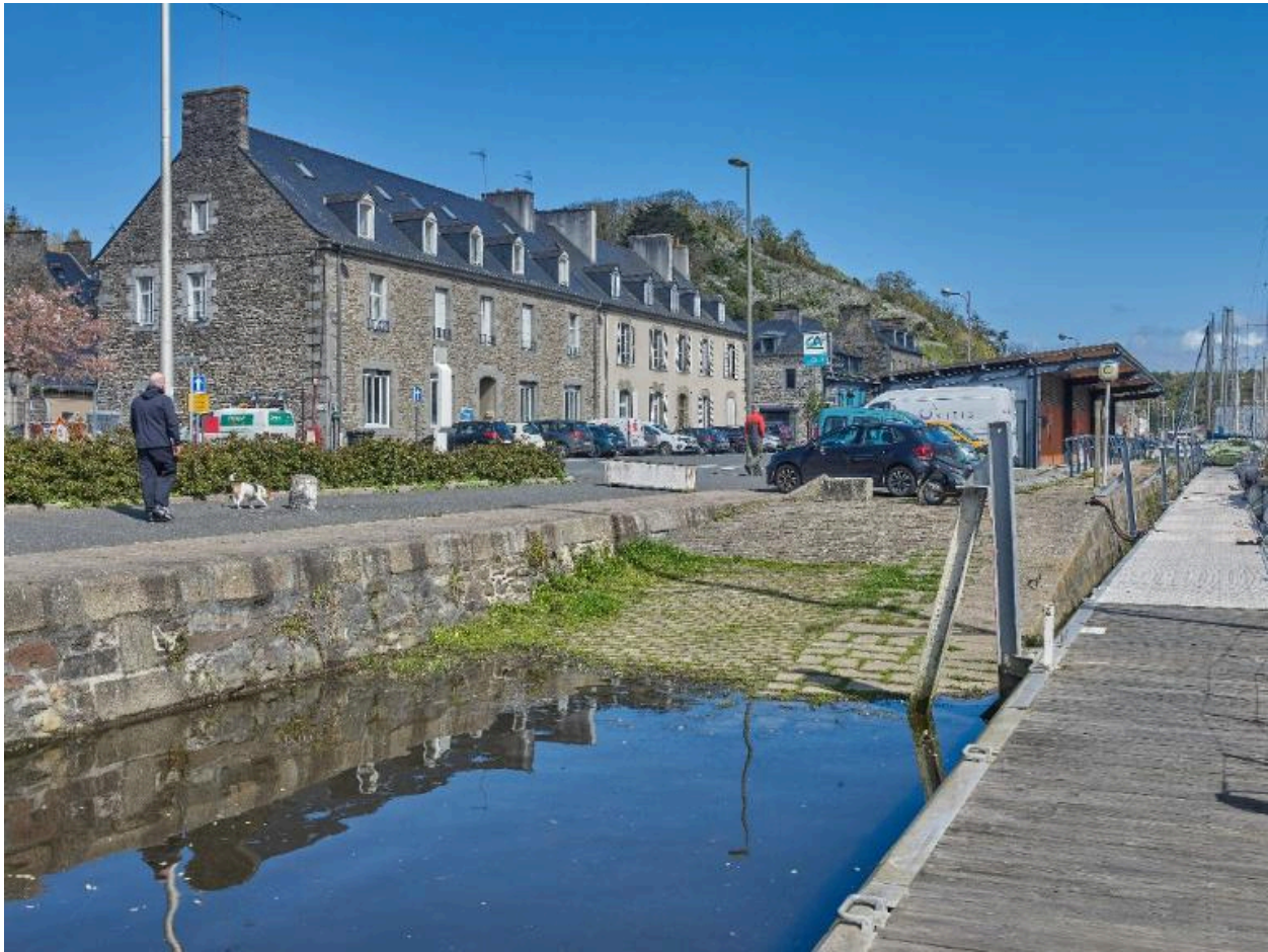
Quai et cale anciennement dénomés d'Aiguillon, plus anciens ouvrages portuaires du port du Légué
