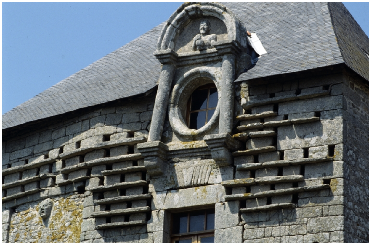
Elévation sud : lucarne
