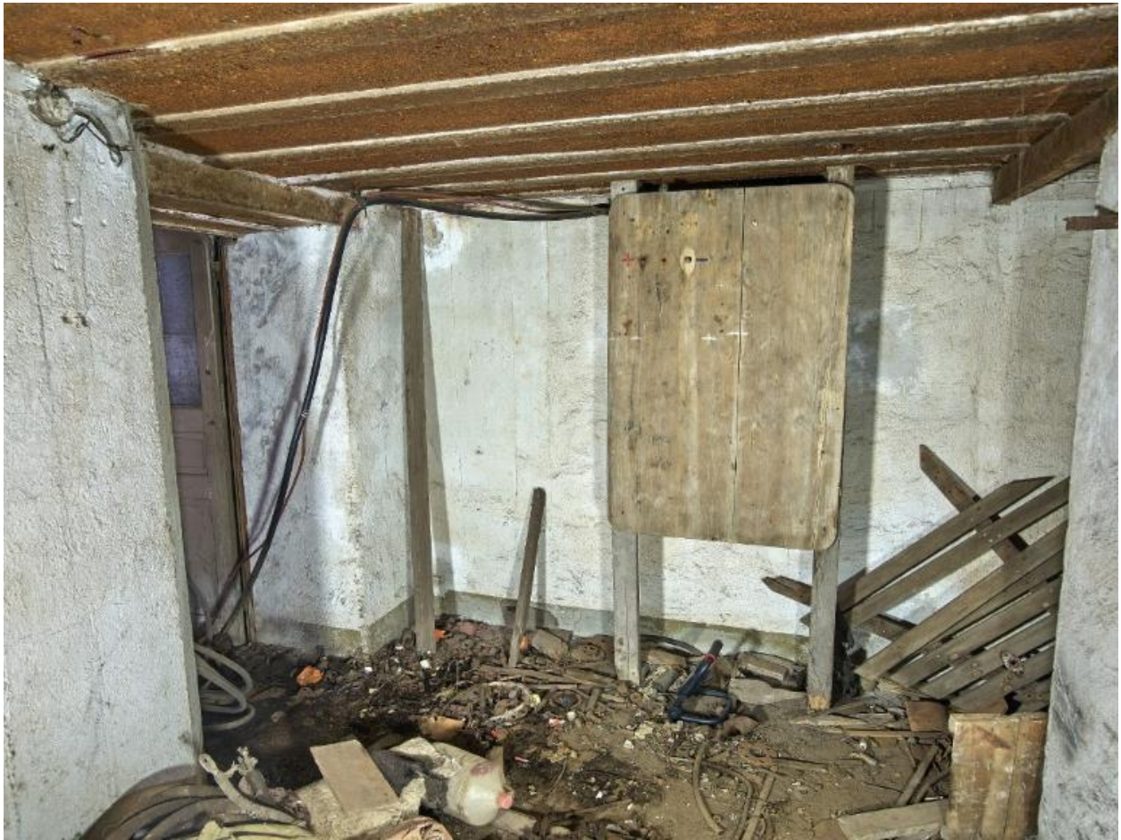
Vue de la chambre de combat : à gauche, l'accès ; au centre, le mur faisant face au poste de tir ; à gauche, l'emplacement du système de ventilation (non visible)
