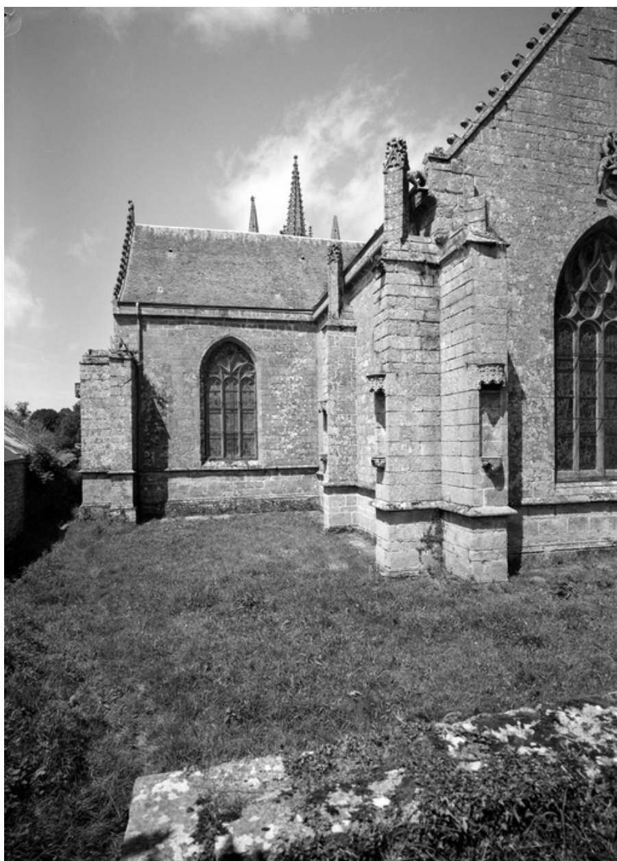
Façade sud, prise du sud-est.
