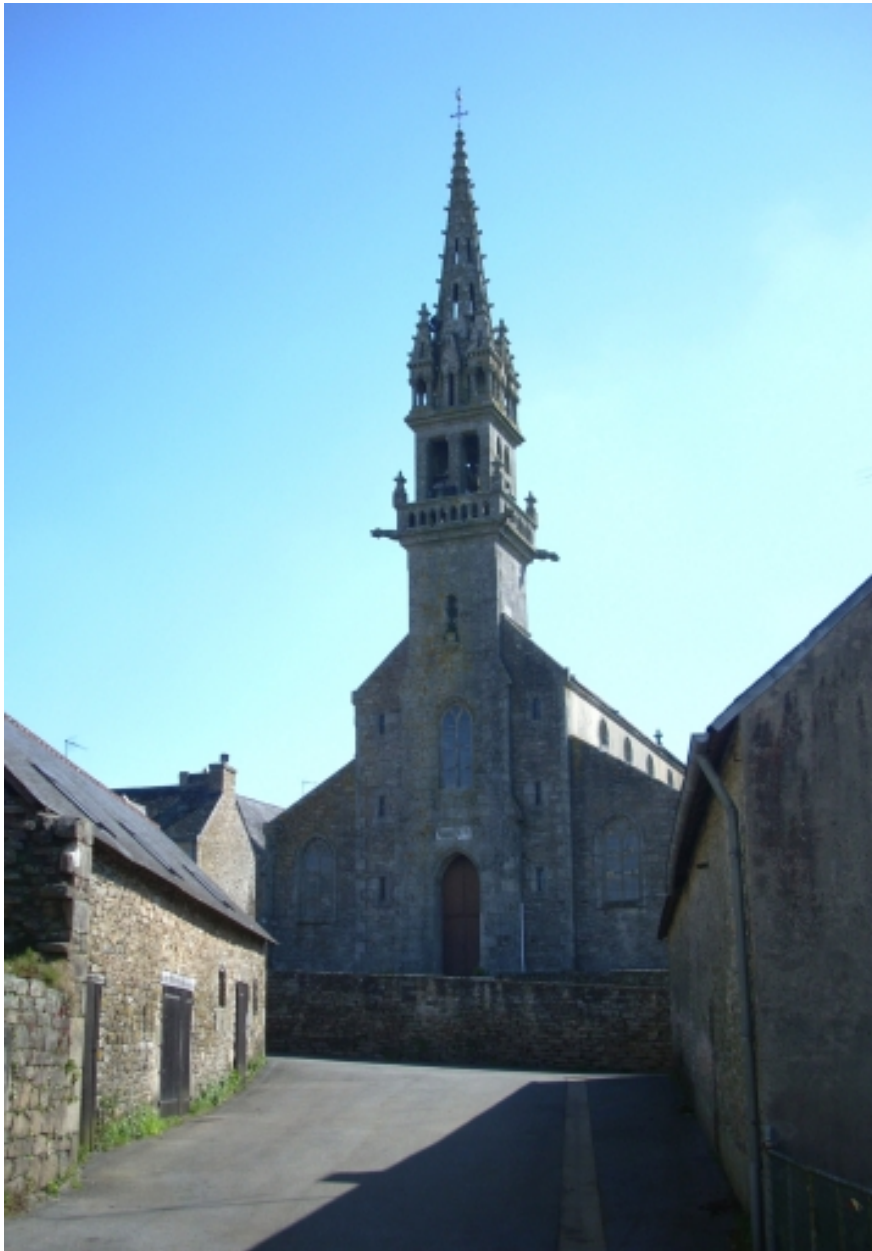
Saint-Thurien, église paroissiale Saint-Thurien : vue générale ouest
