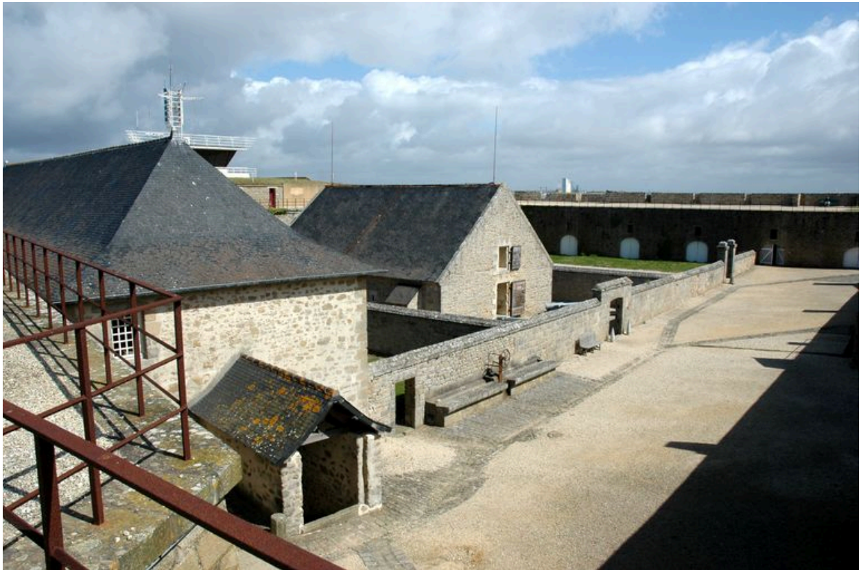
Vue de la citadelle de Port-Louis : arsenal, magasin à poudre et parc à boulets
