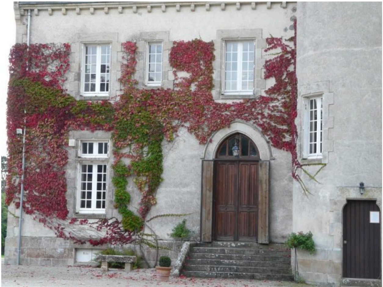
Façade nord, porte d'entrée principale
