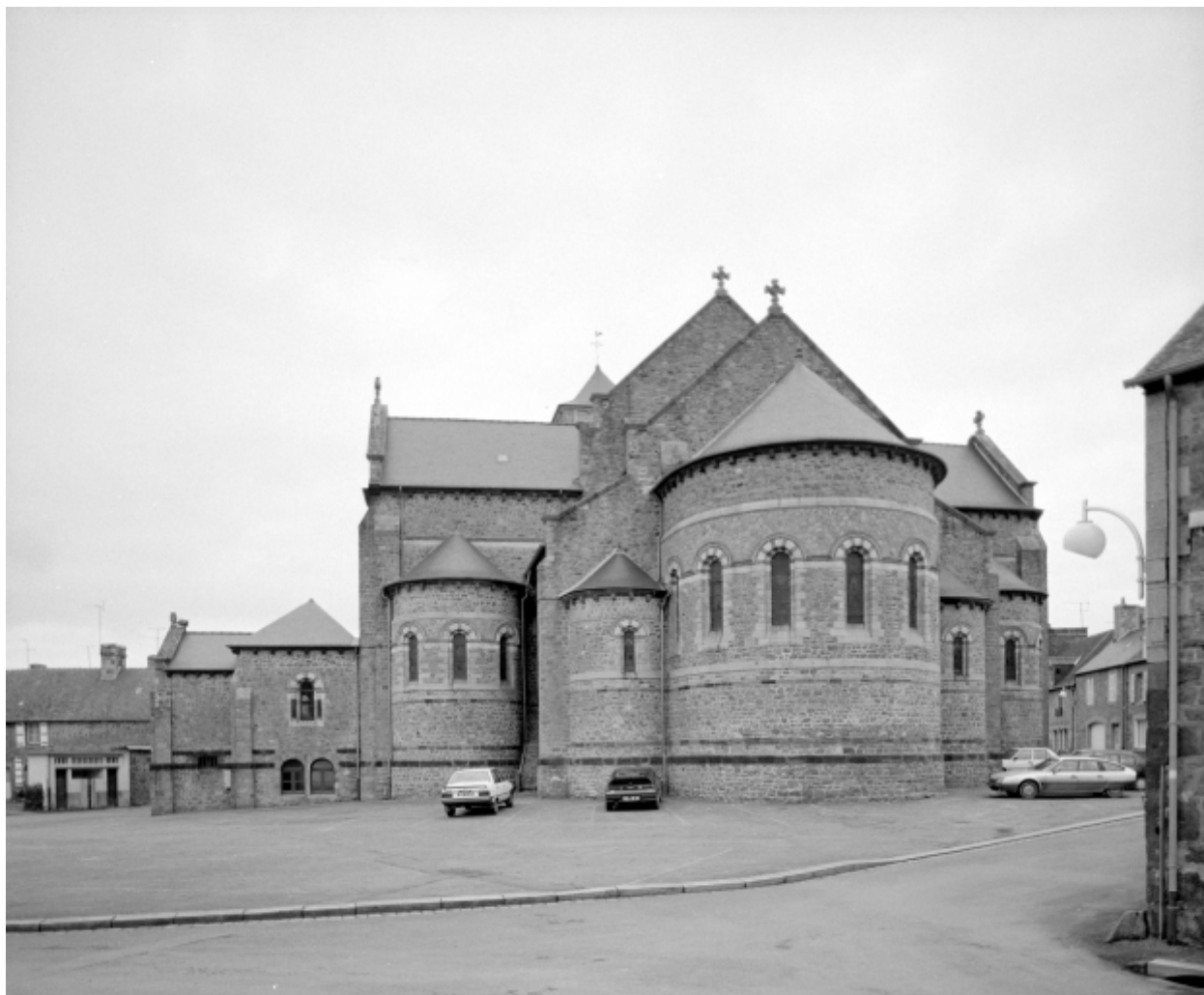
Elévation Sud-Ouest : vue générale
