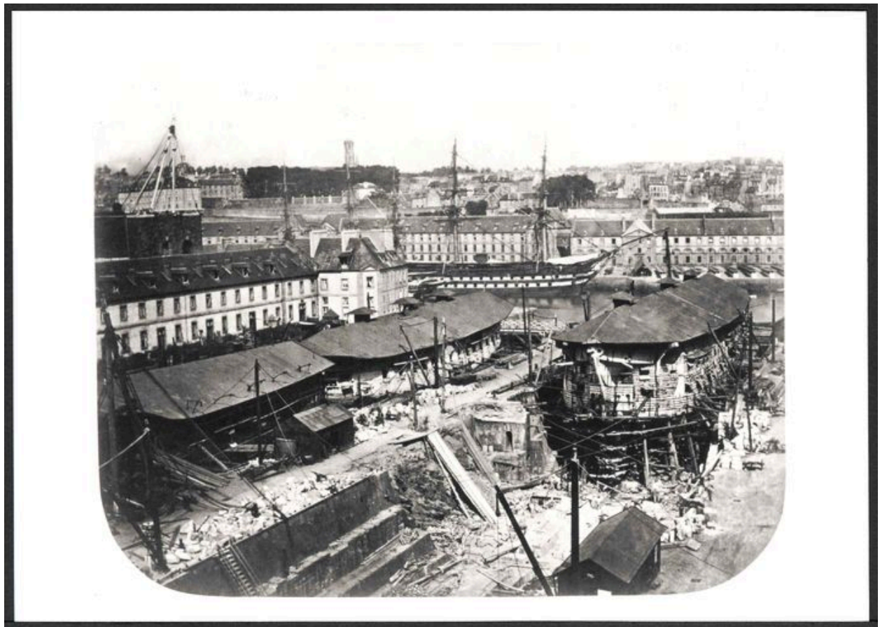
Vue de l'arsenal de Brest en 1859 (?) : formes de construction, bassins de radoub de Pontaniou dits formes de Pontaniou. Au deuxième plan sur l'autre rive de la Penfeld : le Magasin Général
