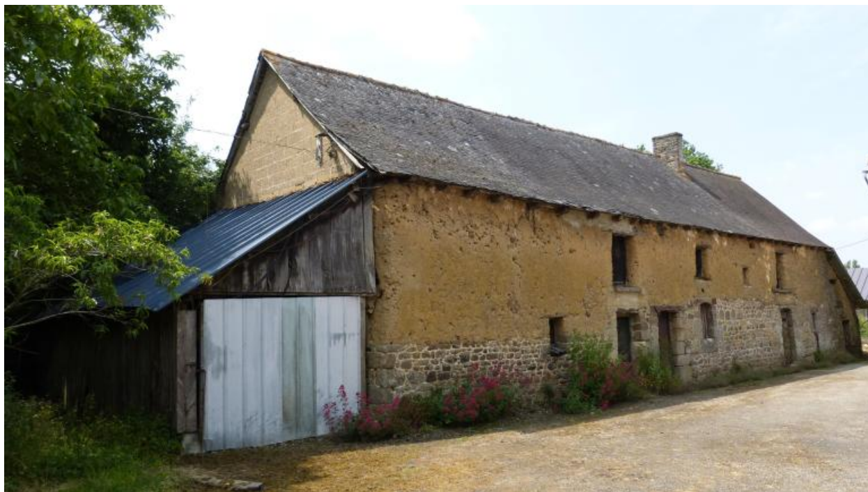
Vue générale de la dépendance, façade est
