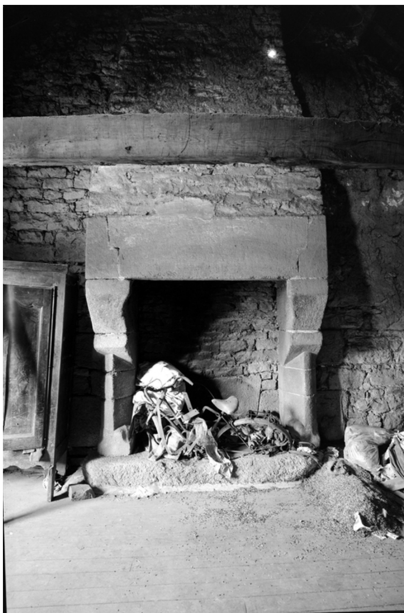
Vue de la cheminée au-dessus du cellier
