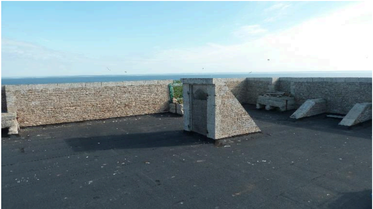
Archipel de Glénan, batterie de Penfret, corps de garde crénelé, la terrasse sans ses banquettes en terre en 2017.
