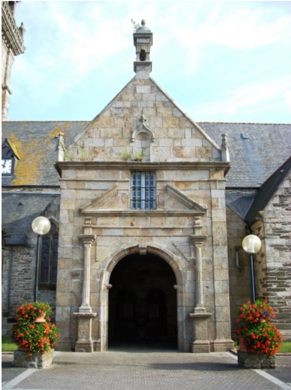
Plouvorn, église paroissiale Saint-Pierre : porche sud, détail
