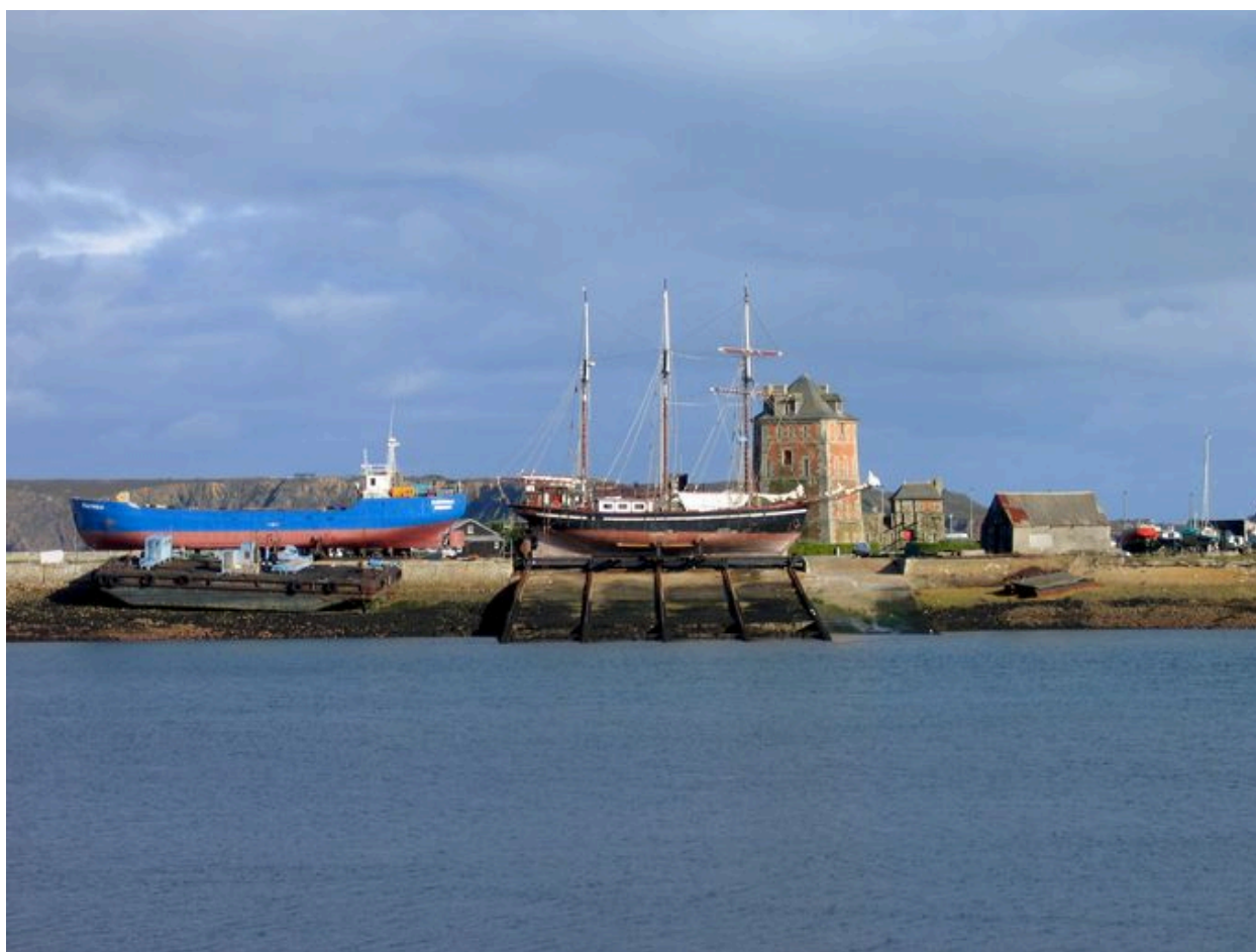
Vue générale du slipway de Camaret
