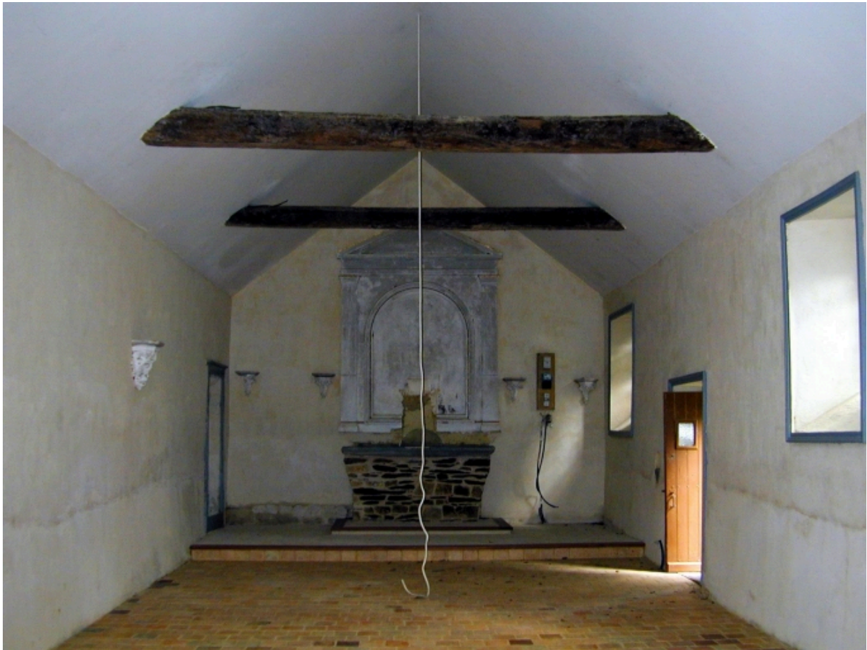
Intérieur : vue générale vers le chœur
