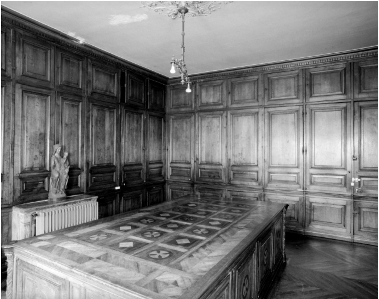
Sacristie - Vue générale.
