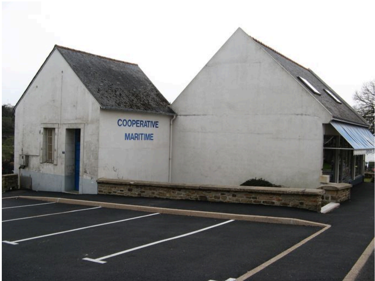
Coopérative maritime vue du parking
