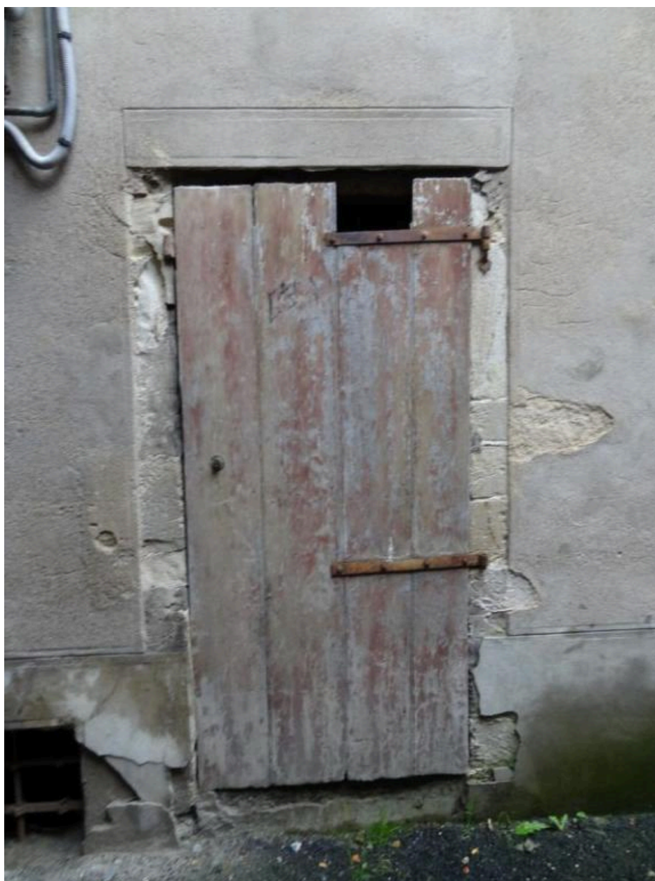
Porte du rez-de-chaussée de la façade ouest
