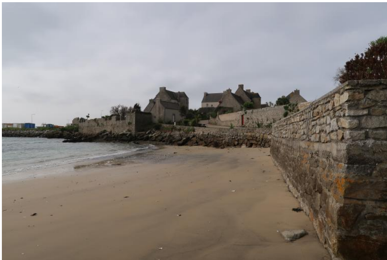
Porz Kernog, murs de soutènement
