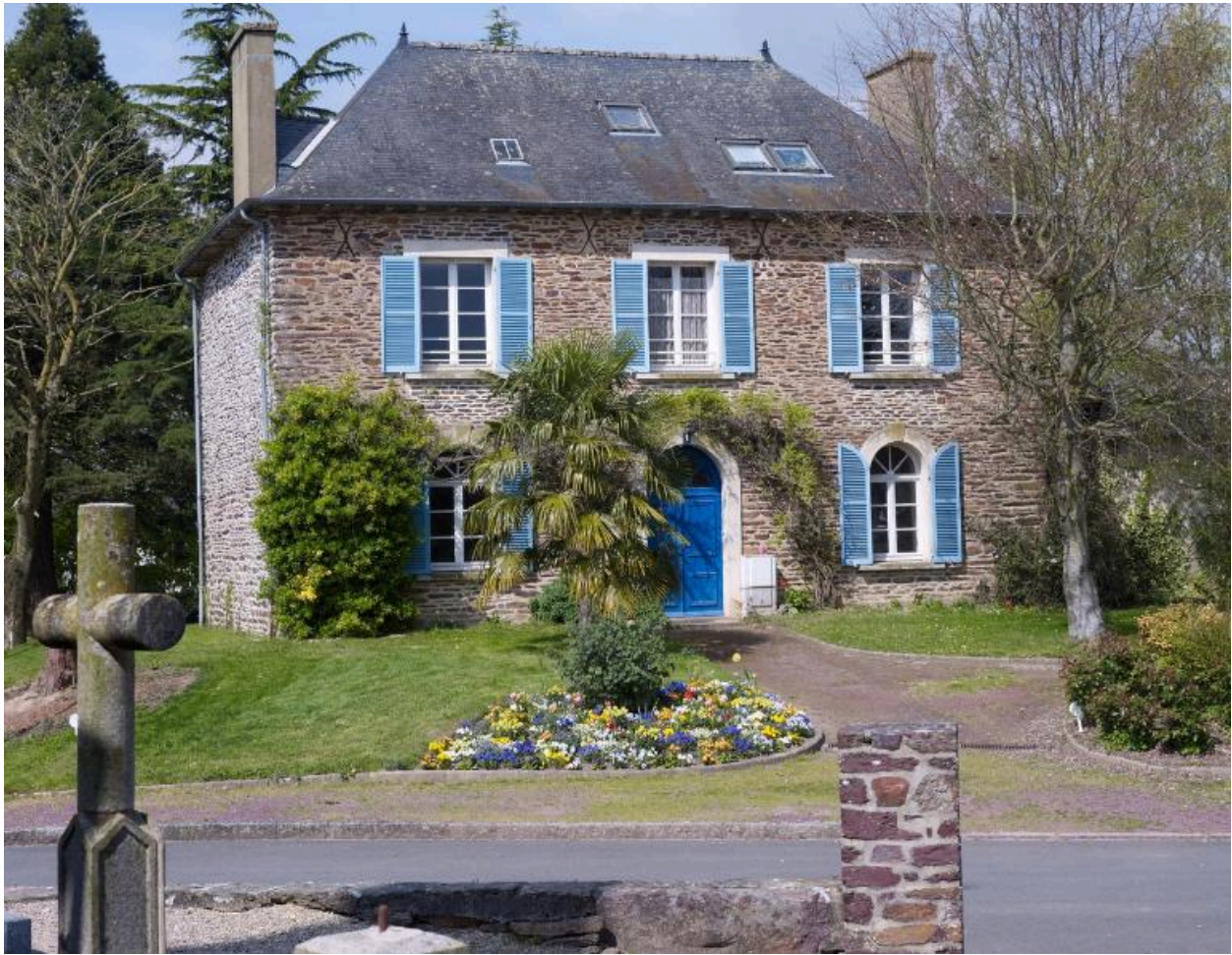
Ancien presbytère, façade principale vue depuis le cimetière de Moigné
