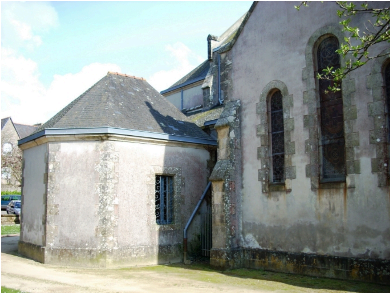
Douarnenez, église paroissiale Saint-Joseph de Tréboul : sacristie vue du nord-ouest
