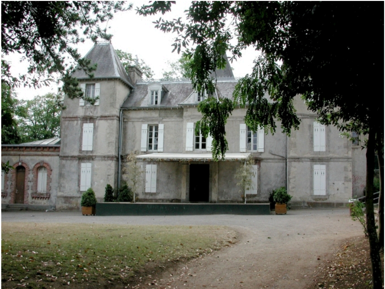
Vue générale de la façade antérieure.
