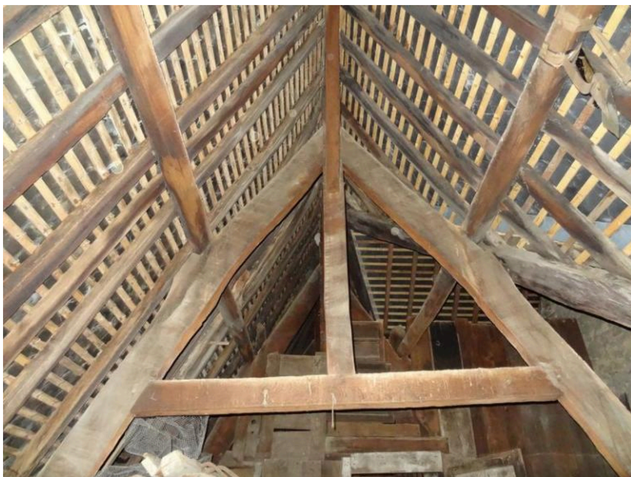
Détail d'une ferme de charpente
