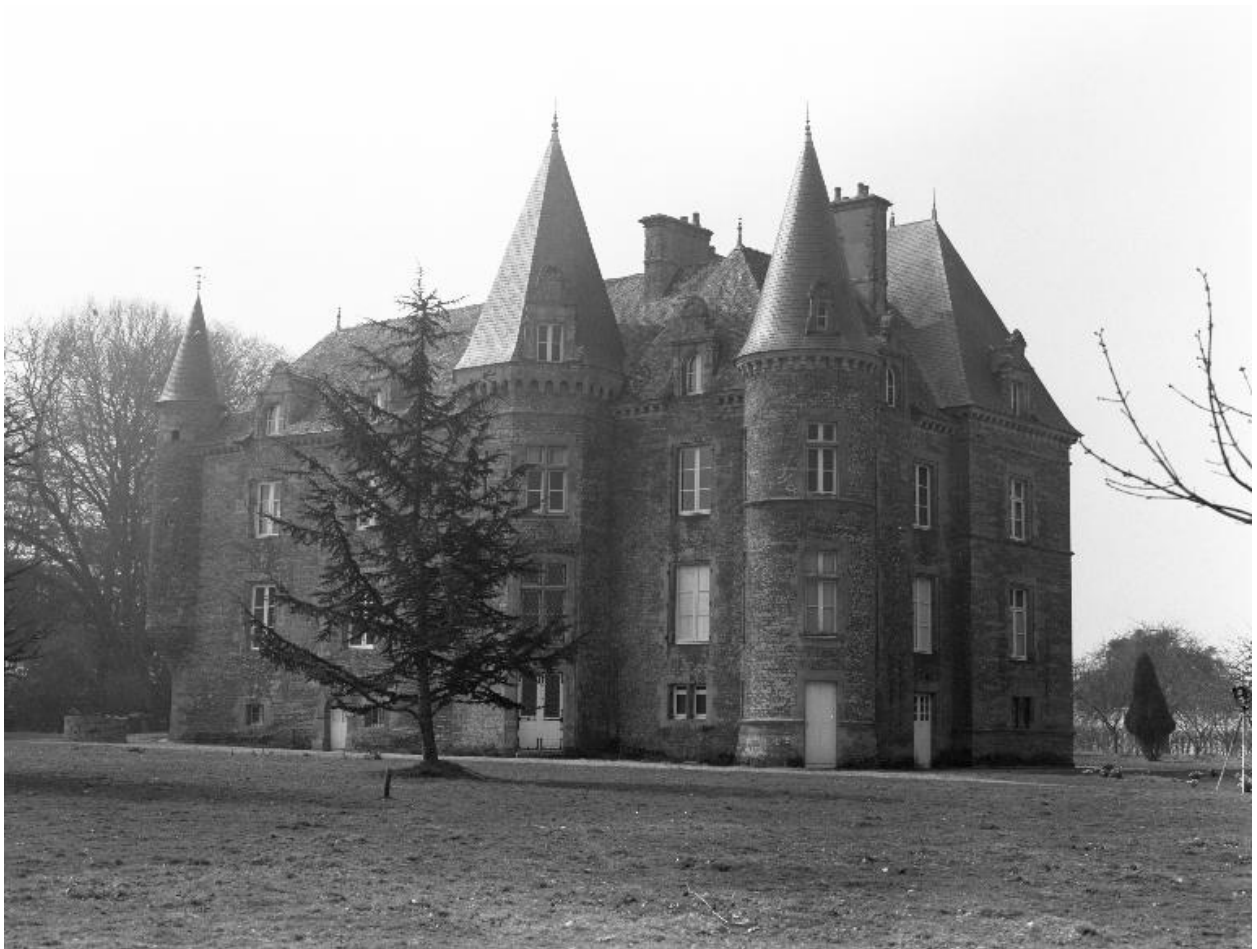
Manoir : vue générale nord-est (état en 1984)
