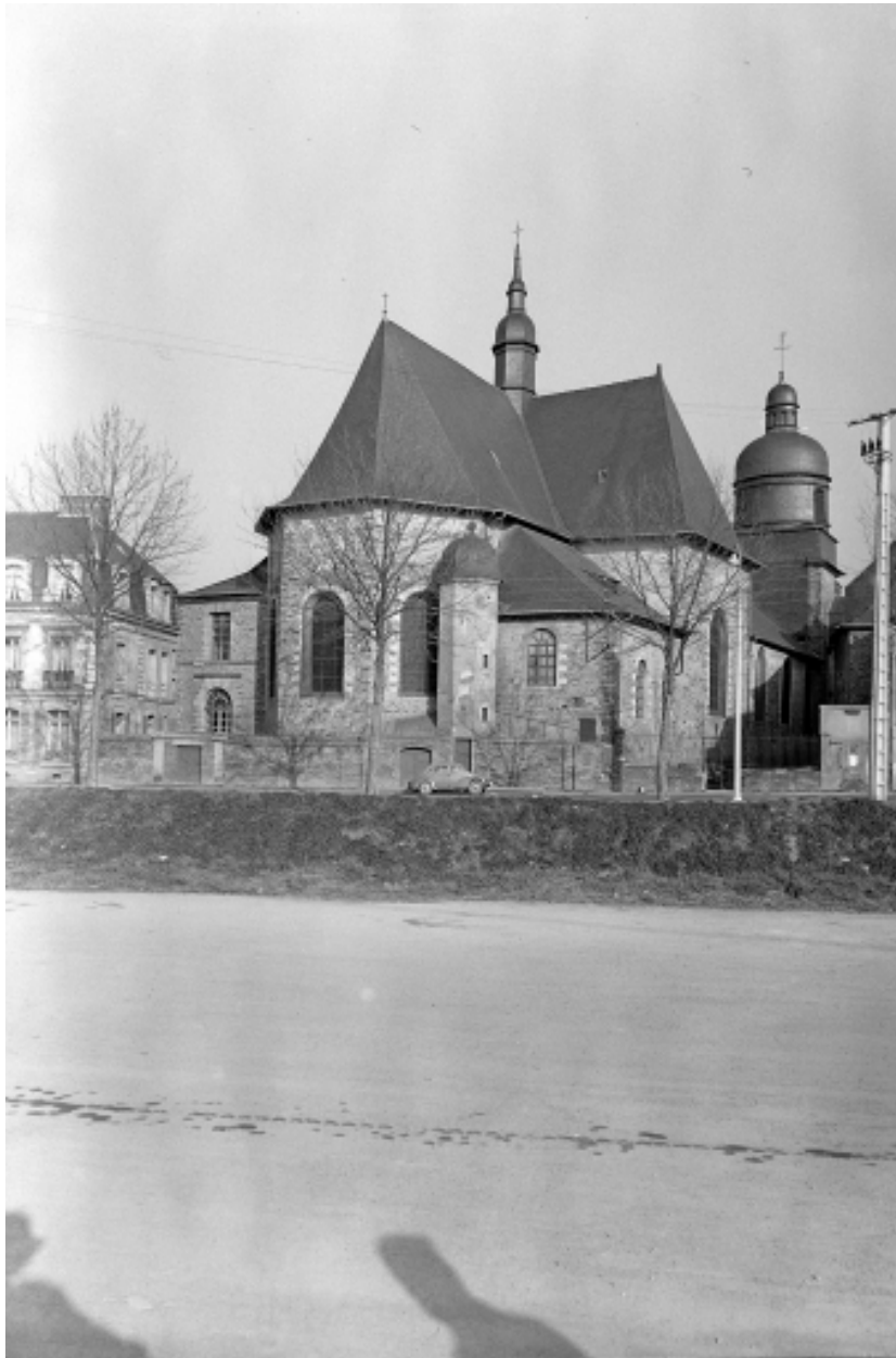
Rennes - Eglise Saint Etienne - Elévation ouest, vue de situation.
