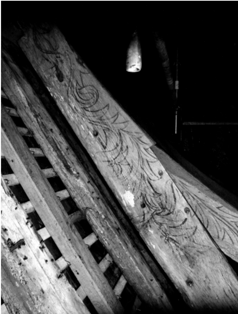
Détail sous charpente.
