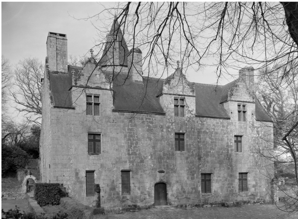
Logis, élévation antérieure : vue générale prise du sud-est.
