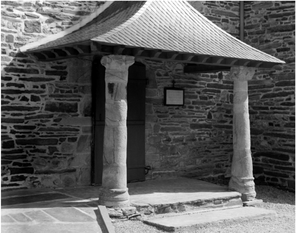
Elévation Sud, porte : vue générale
