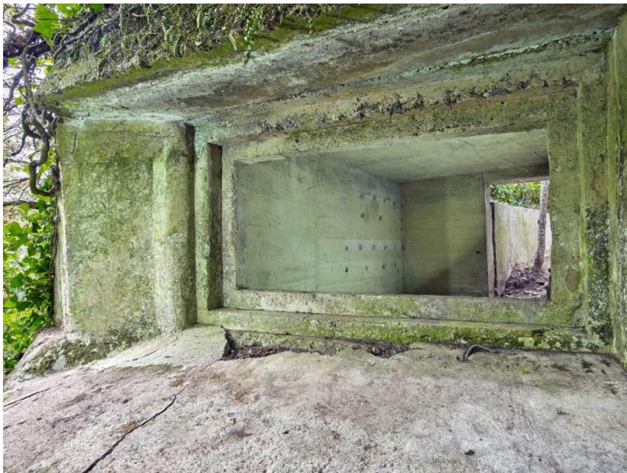
Vue de l'embrasure rectangulaire en gradin depuis l'extérieur
