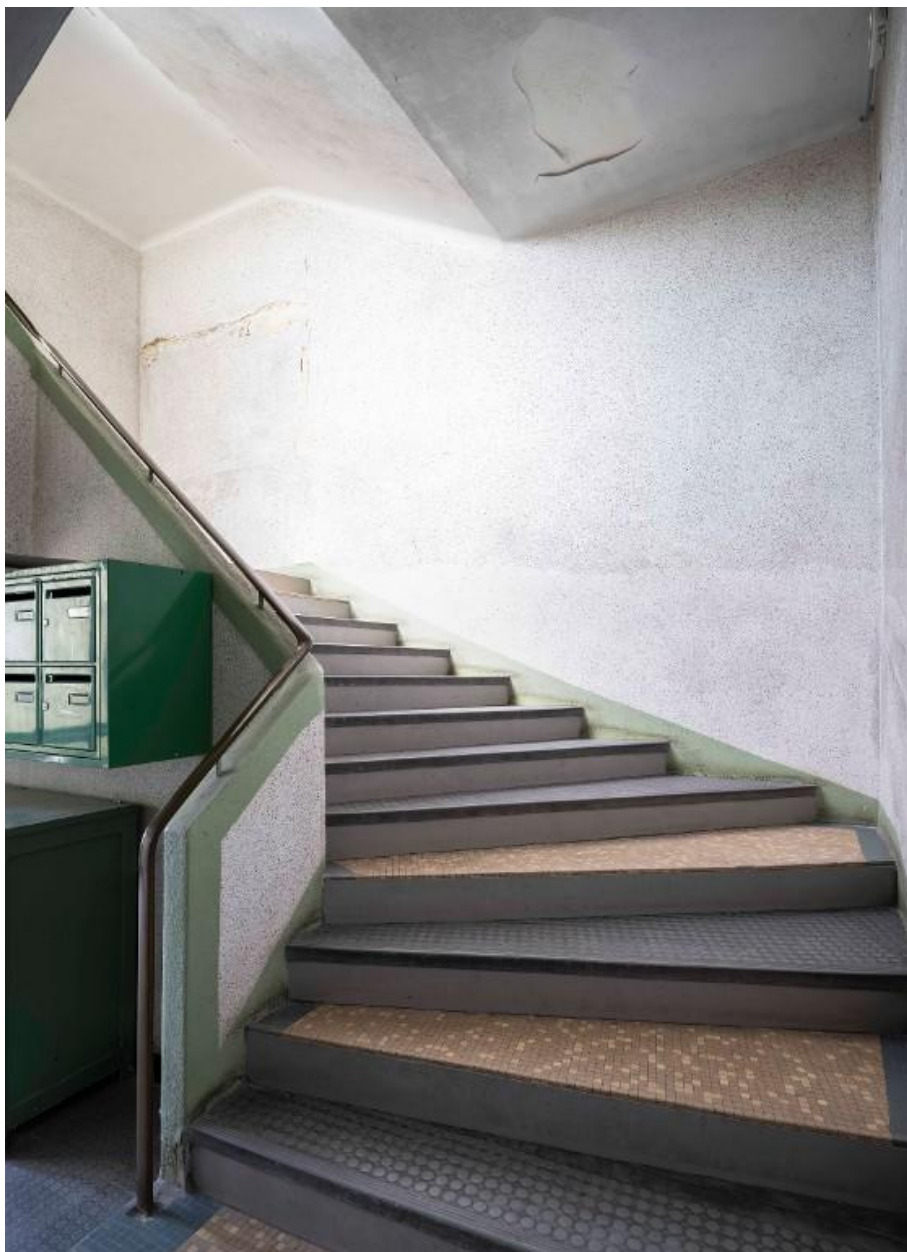
Escalier et palier de la criée de 1952
