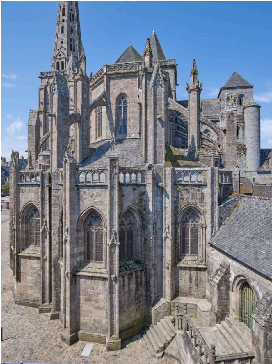
Vue générale du chevet. Au premier plan à droite, entrée sud du cloître
