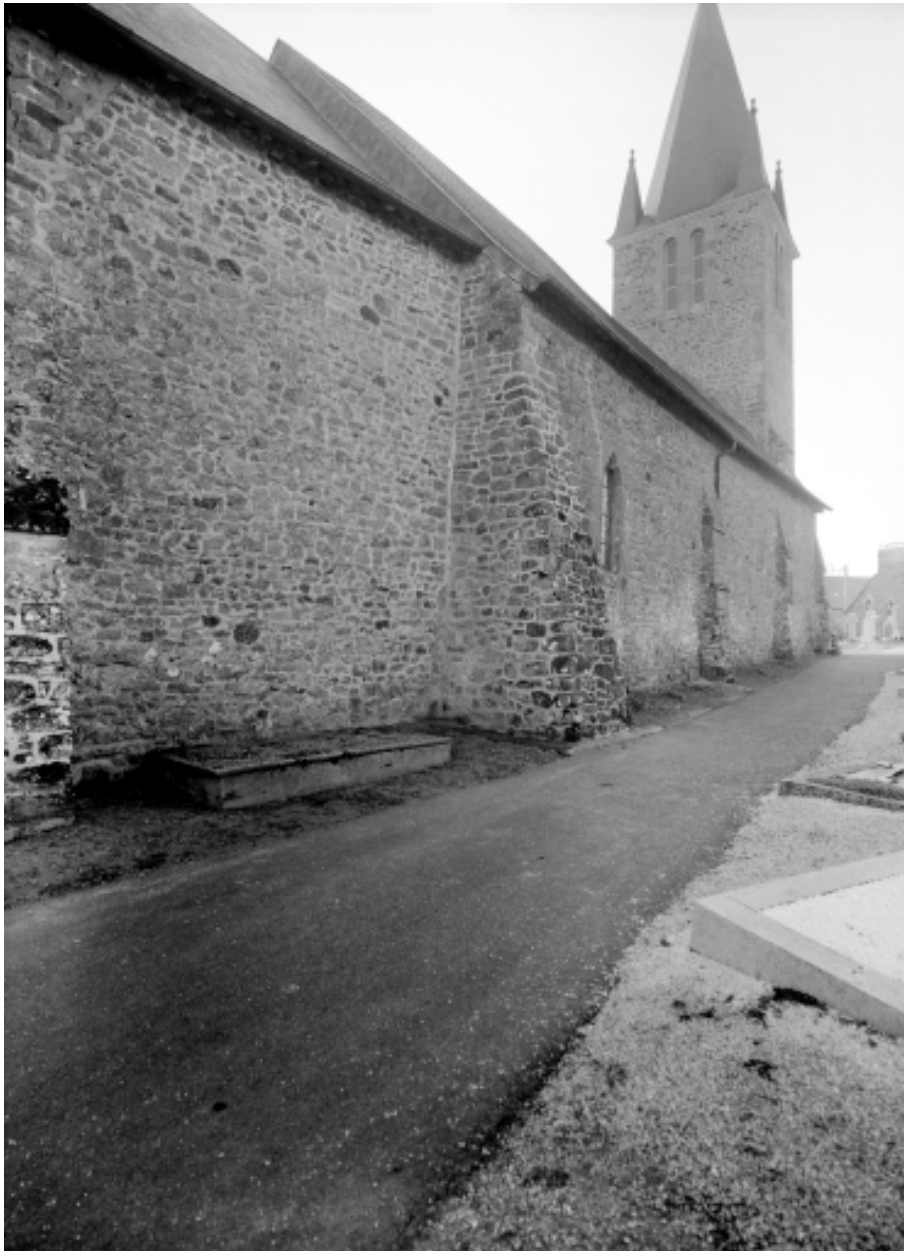
Elévation nord, partie centrale : détail de l'alignement
