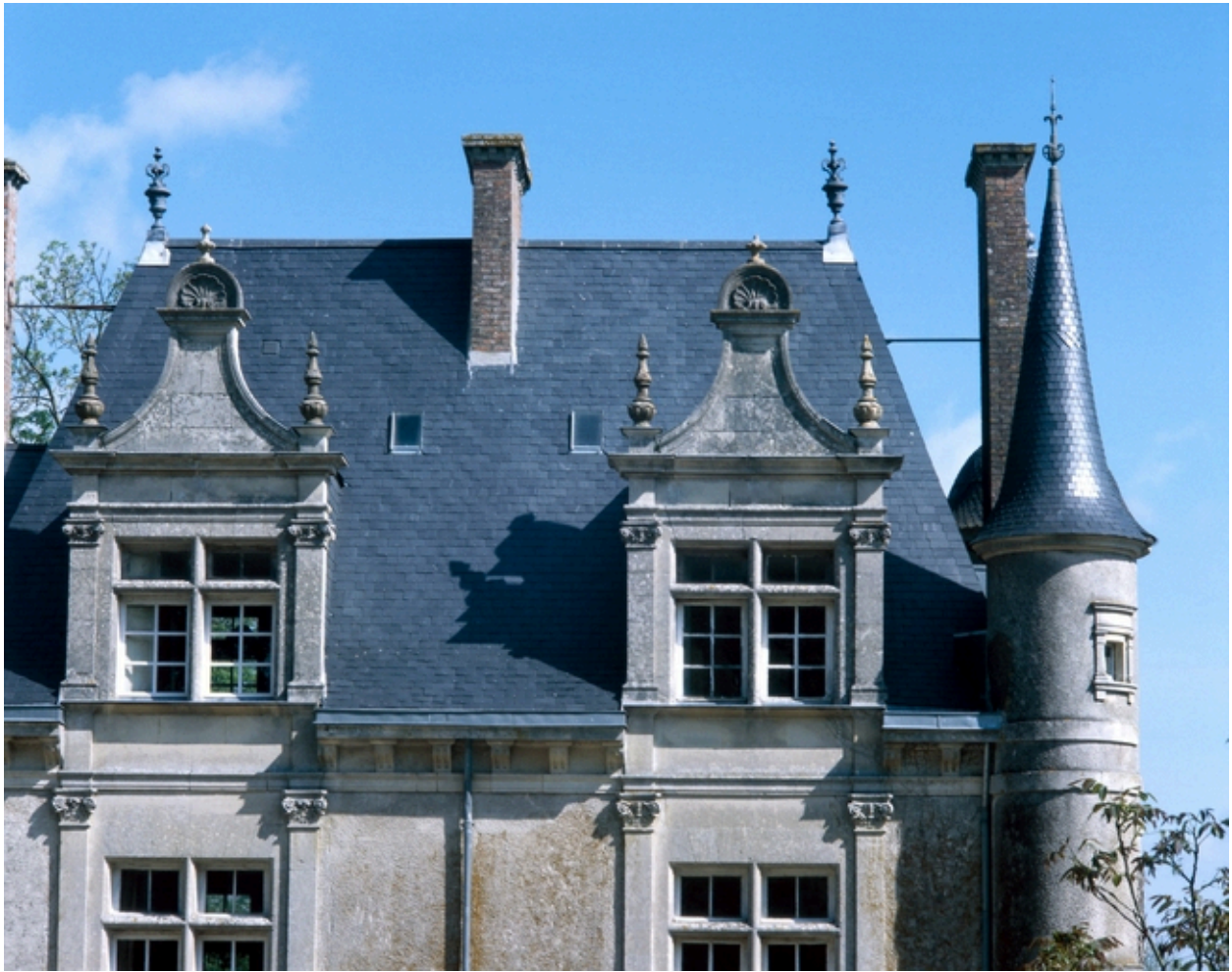
Elévation sud, partie supérieure.
