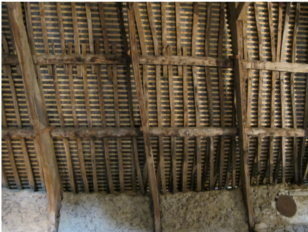
La grange, détail de la charpente
