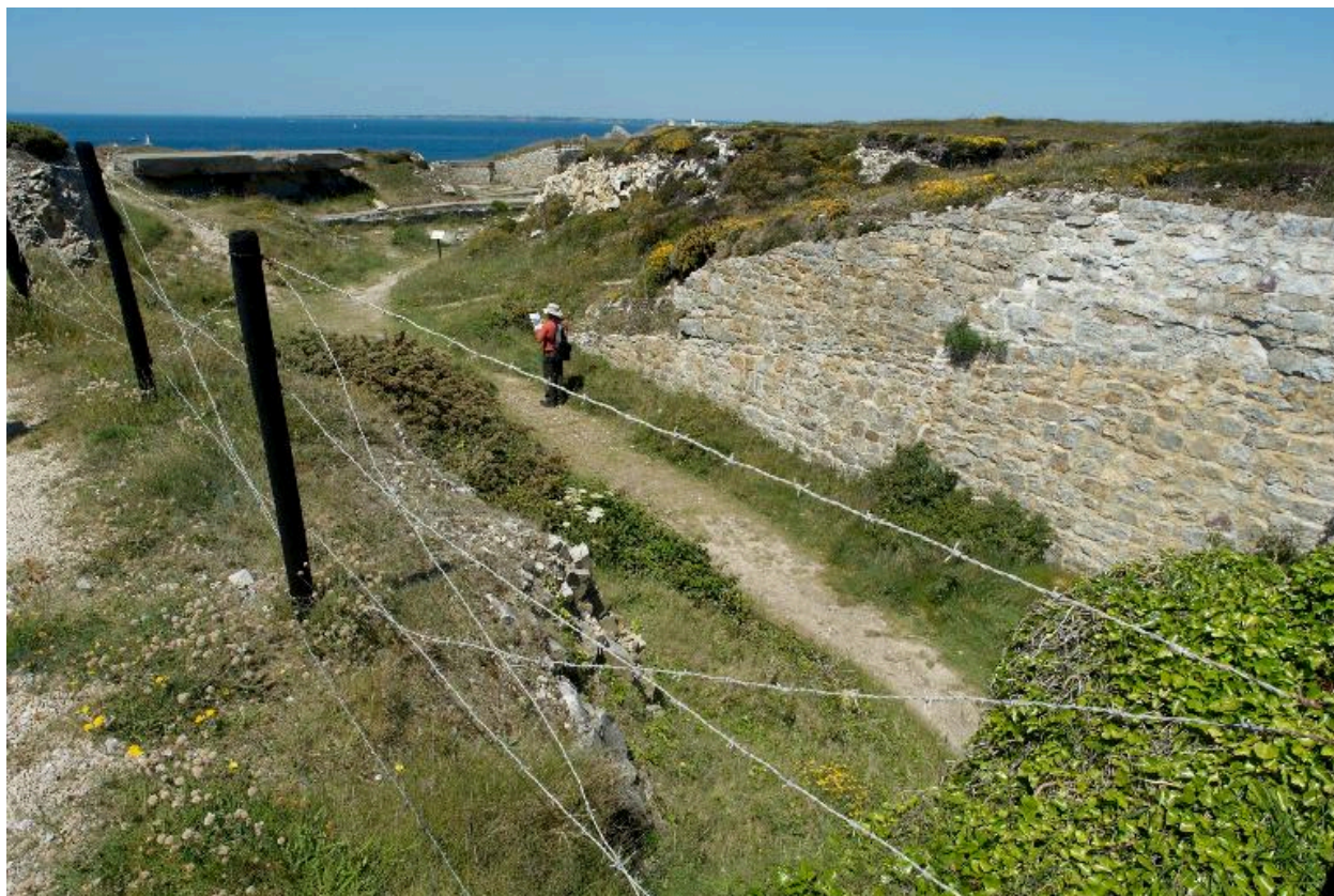
Vue de la batterie de mortier
