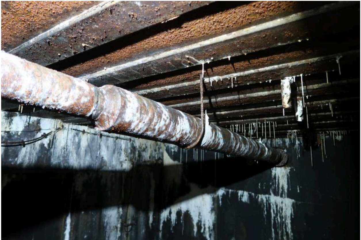
Vue de la pièce de vie - chambre de troupe : tuyau du système de ventilation (état au 11 octobre 2022)
