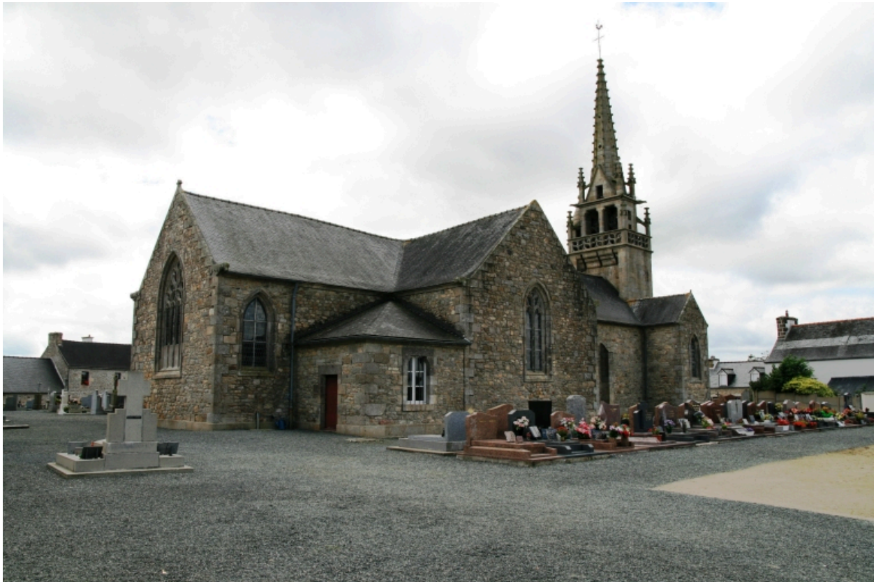
Plouégat-Moysan, église paroissiale Saint-Pierre : vue générale nord-est
