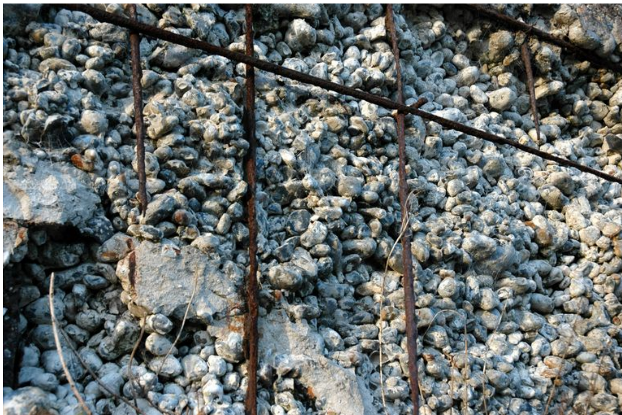
Pas-de-Calais : vue de détail d'un abri de la batterie Waldam dite batterie du fort Vert
