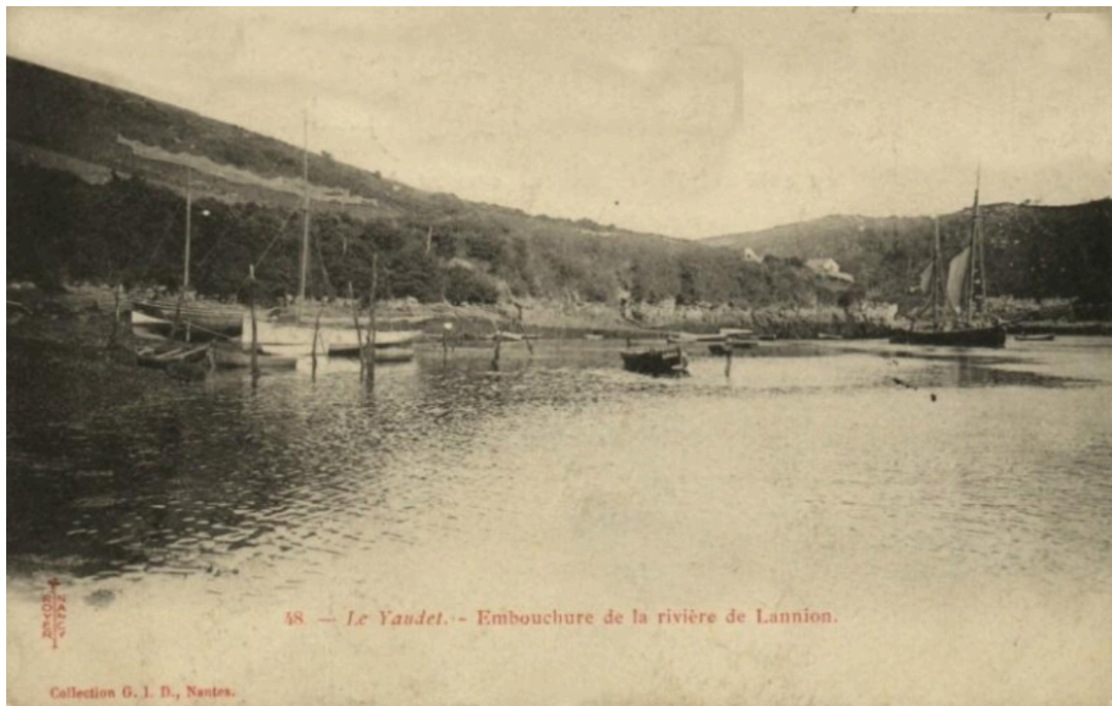
Le port du Yaudet : amarrage traditionnel sur pieux
