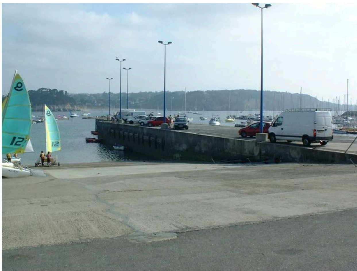
Cale de mise à l'eau du Kador
