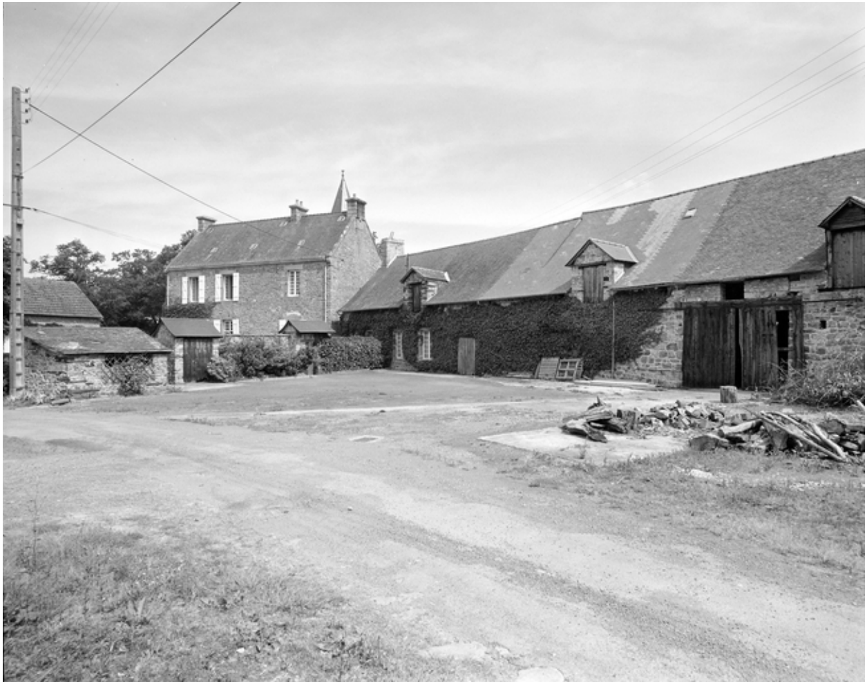
Vue générale depuis la première cour.
