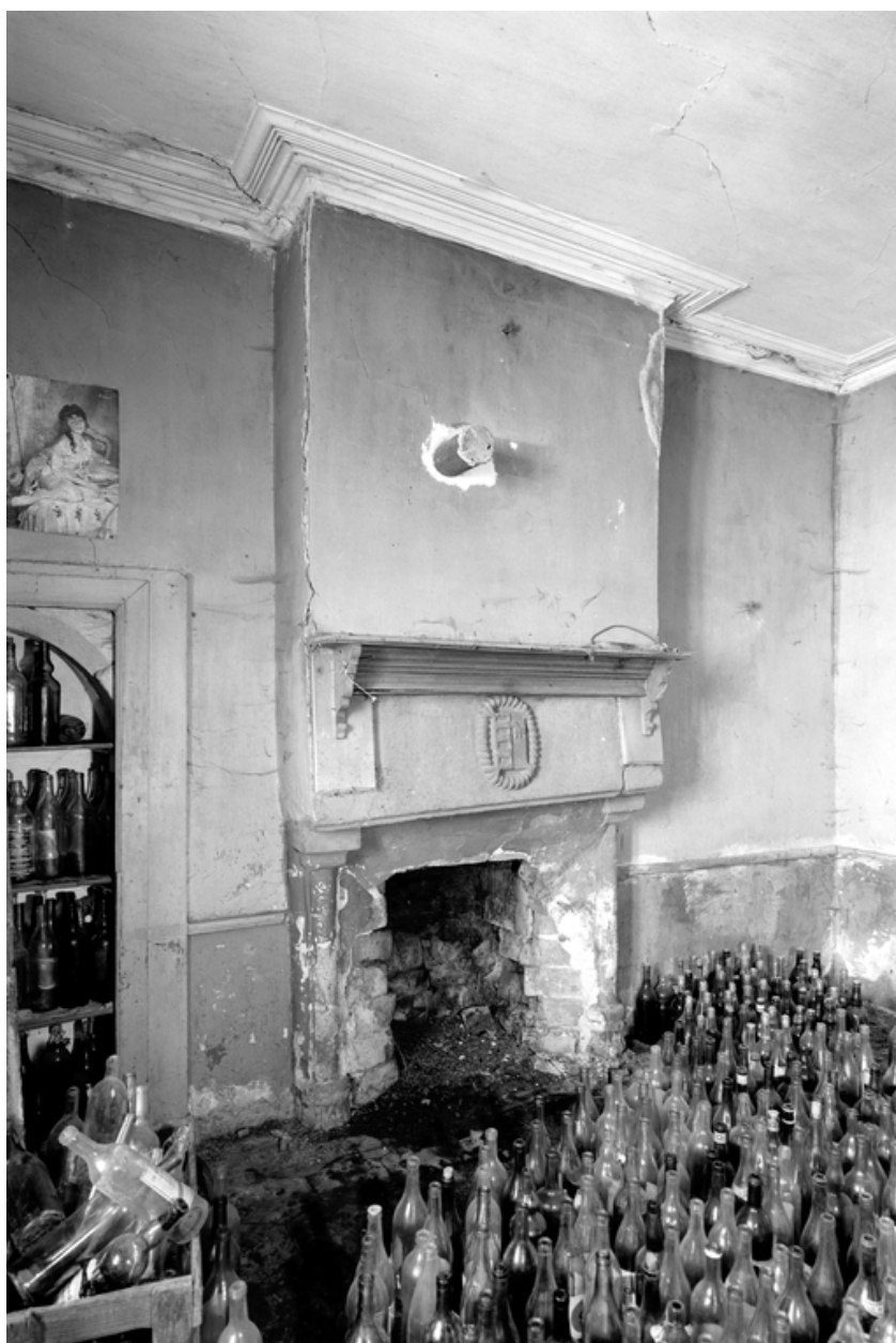
Aile ouest : cheminée du rez-de-chaussée
