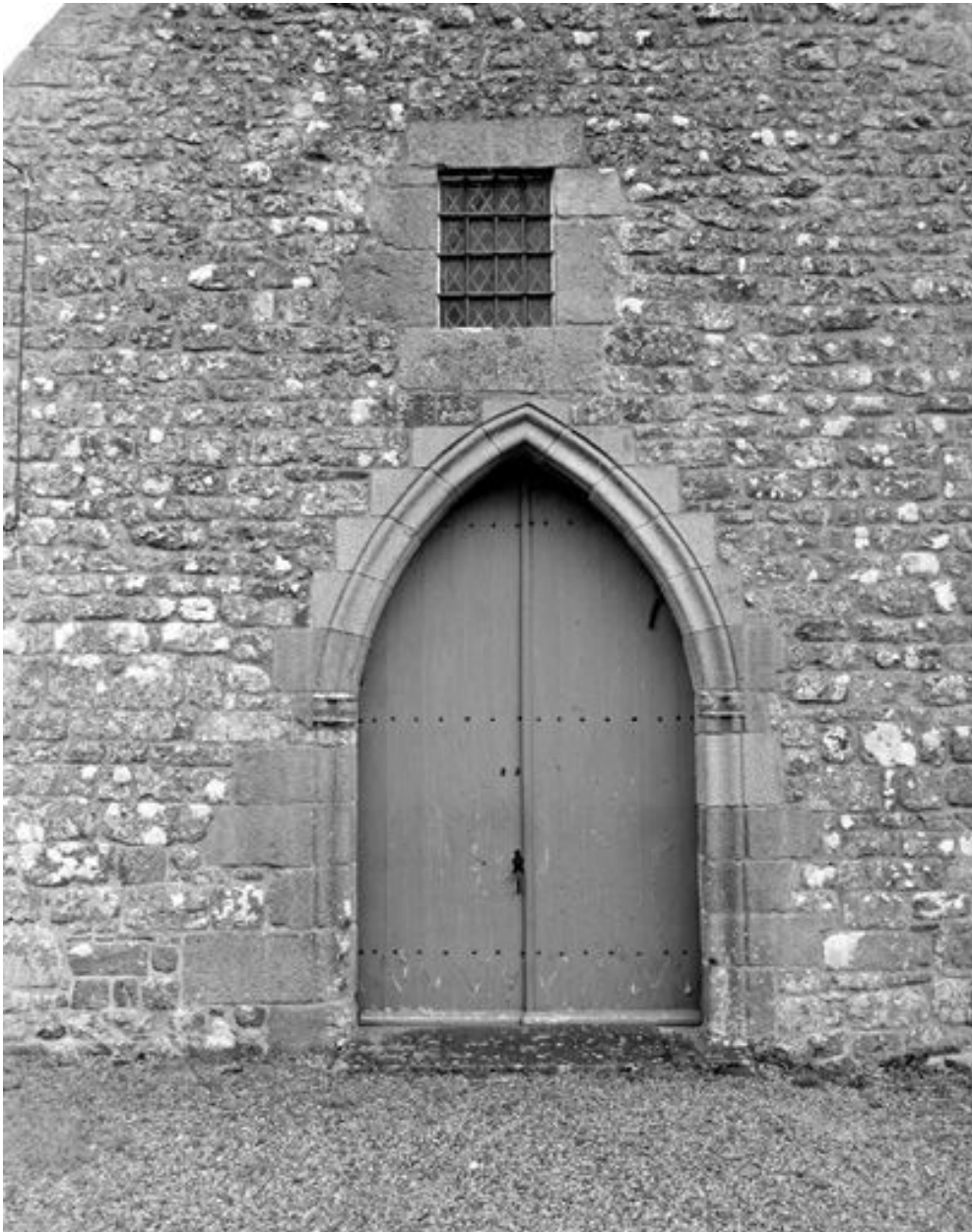
Elévation ouest, porte
