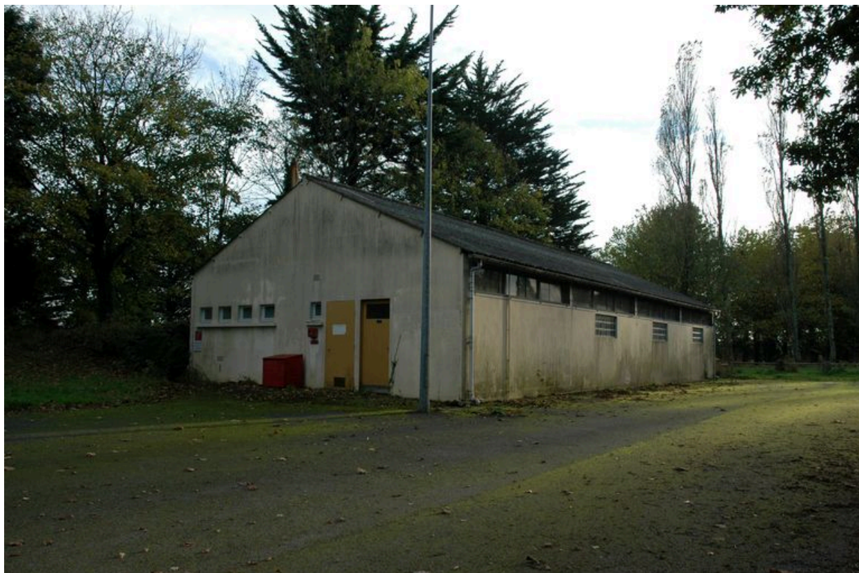
Vue du fort de Penfeld : bâtiment situé devant l'entrée
